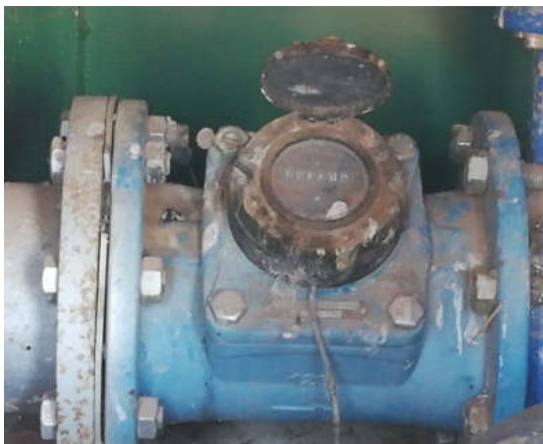
Figura 4.11. Visualización del contador dentro del registro. Tapa levantada. Se puede tomar lectura y ver los precintos.
