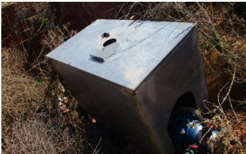
Figura 3.6. Correcto. Arqueta con visor. Hay que comprobar que el tamaño y ubicación es el adecuado para poder realizar las comprobaciones oportunas.
