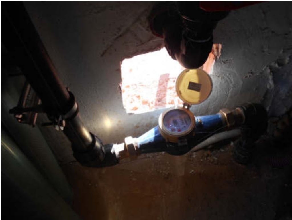
Figura 4.12. Visualización del contador dentro del registro. Tapa levantada. Visto desde el interior de la instalación.
