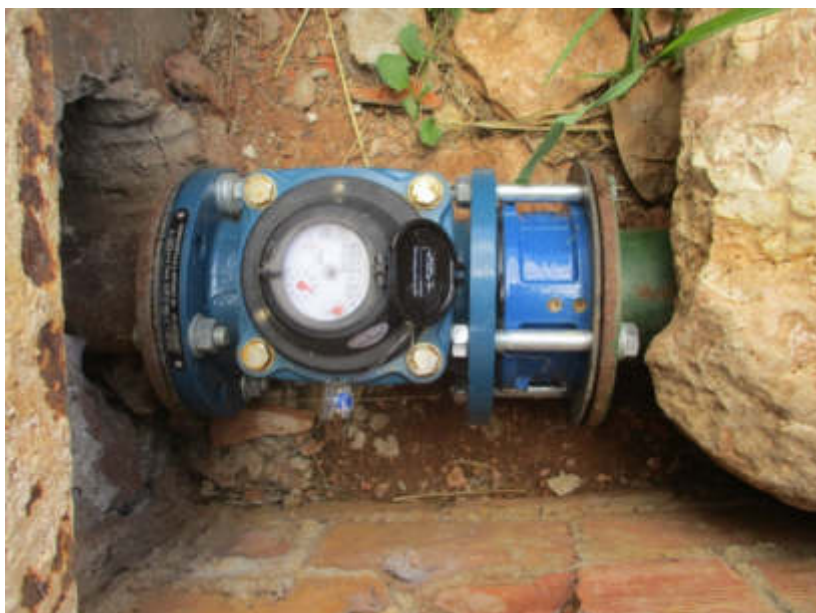
Figura 4.2. Correcto. Tubo pasante, situando el contador en el exterior. Hay que comprobar la integridad de la tubería aguas arriba del contador, entre el mismo y la captación, antes de precintarlo.
