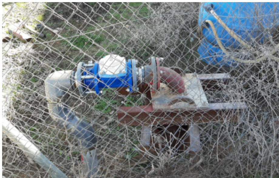
Figura 5.1. Incorrecto. Contador junto a valla de simple torsión doble. Para facilitar el acceso se puede abrir una venta en la malla o dejar la tapa abierta.
