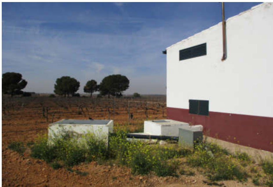
Figura 3.4. Correcto. Pozo dentro de arqueta cerrada (izq.), contador a la derecha, en arqueta abierta. Tubería de conexión visible.
