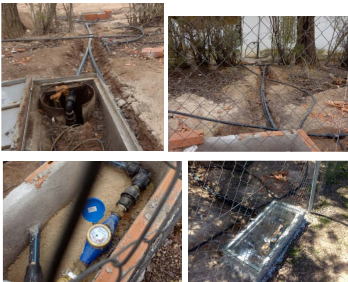
Figura 5.4. Correcto. Contador dentro de vallado. Tubería entre pozo y valla. Hay que asegurarse de que el contador queda instalado en la dirección del flujo. Tapa de policarbonato en arqueta
