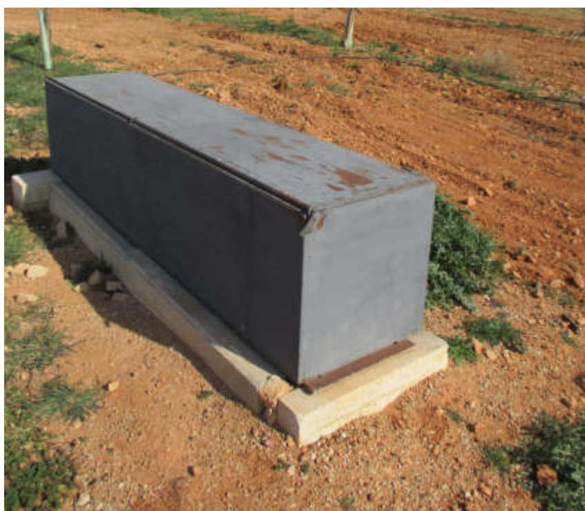
Figura 3.3. Incorrecto. Arqueta cerrada que no permite ver el contador. Un visor en la parte de arriba sería suficiente.
