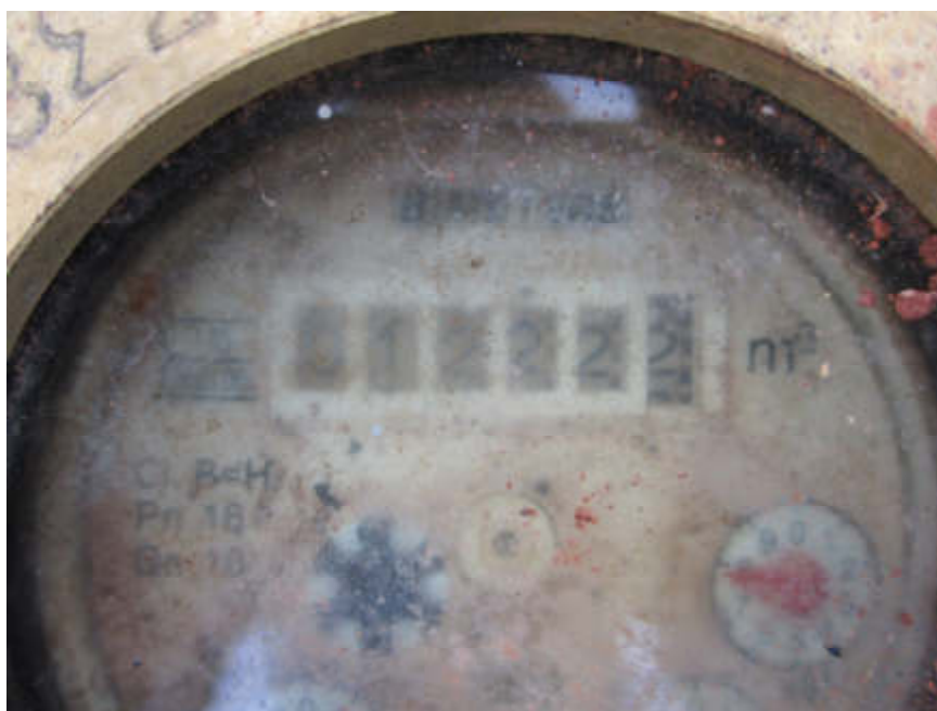
Figura 7.5. Esfera sucia y de difícil lectura. Si la misma está inaccesible dentro de arqueta, no se puede tomar la lectura. Es necesario mantenerla limpia.
