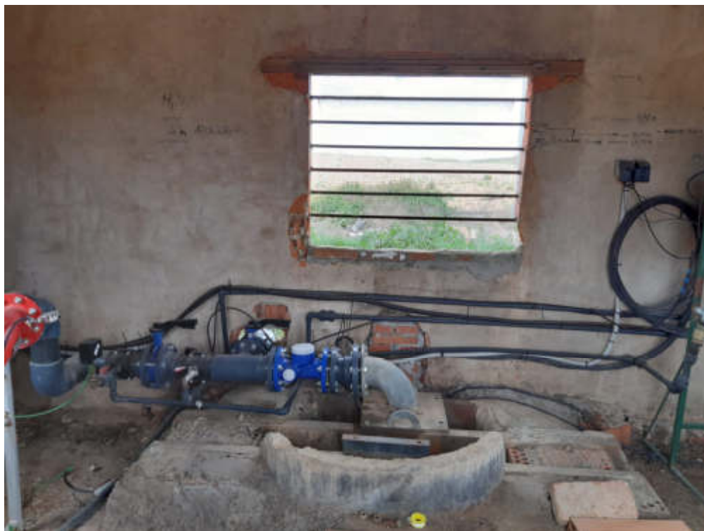
Figura 4.6. Correcto. Ventana que permite ver el contador desde el exterior. Ver imágenes siguientes. Nótese que el contador no es válido para la gestión del DPH.
