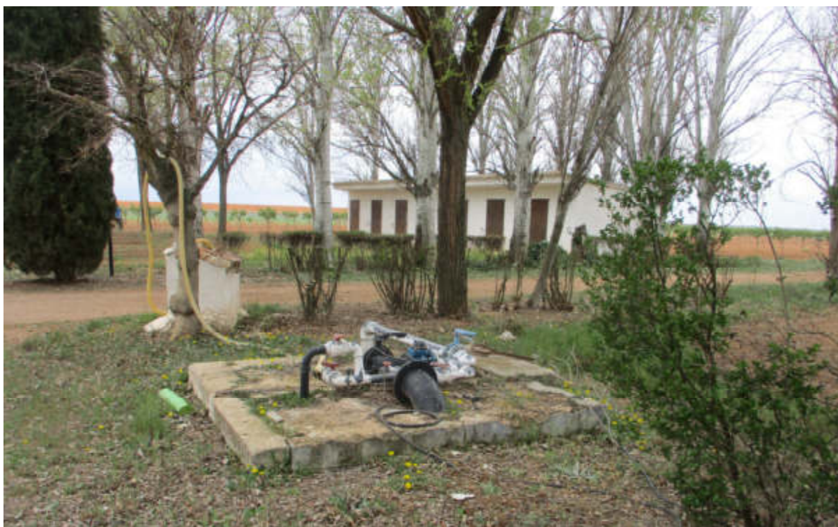
Figura 6.1. Contador accesible. Si se decide cerrar el complejo debe diseñarse el sistema que permita garantizar la accesibilidad del contador.
