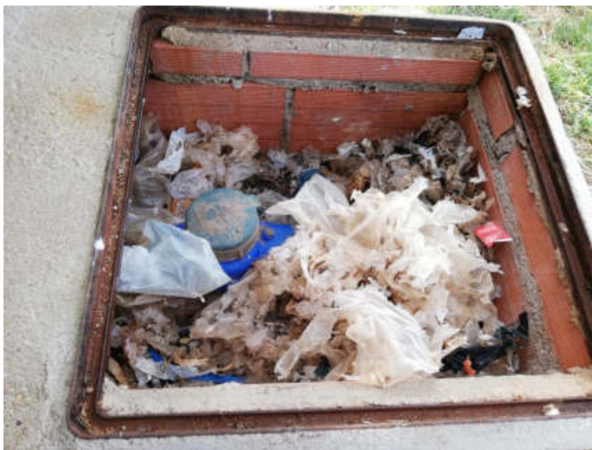
Figura 2.1. Contador en arqueta con nido de ratones. Estado tras retirar parte de la suciedad
